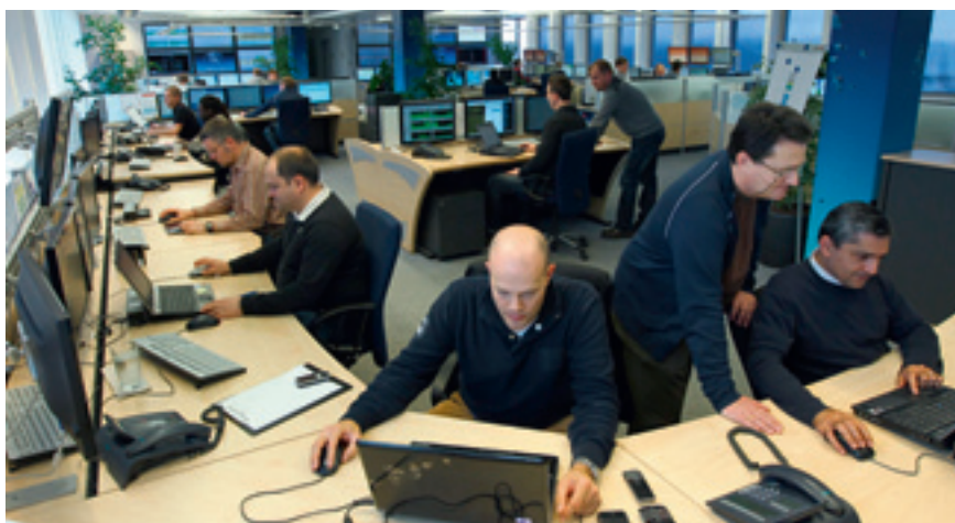
Blick in die Netzzentrale der Telefónica Germany in München.
